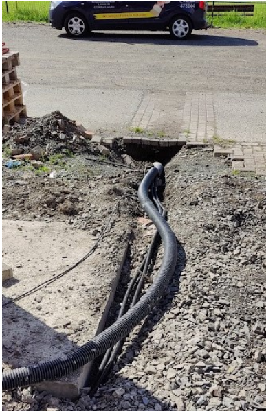
Kabel für Soundanlage Außen ist verlegt und wird in der Halle angeschlossen.
